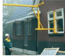
7a. Kozijnen worden kant-en-klaar in de buitengevel geplaatst. (bron: TNO bouw)
