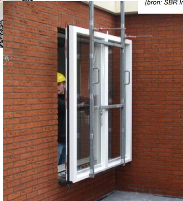
7b. Enkele onderdelen van het KAPLAKozijn. (bron: SBR Infoblad 257)
